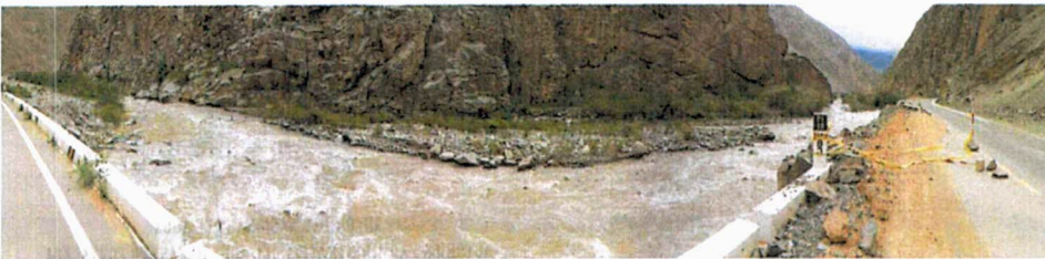
VISTA PANORAMICA DEL PUNTO CRÍTICO SOCABA LOS CIMIENTOS DESTRUYENDO LA CARRETERA
